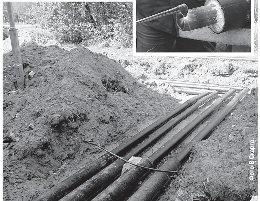
Капитальный ремонт трубопроводов отопления и ГВС от ТК-1-31 до ж/д №4 9-го квартала выполняют работники теплосилового цеха (начальник А.Н. Алёхин) ЗАО «Радугазэнерго».
