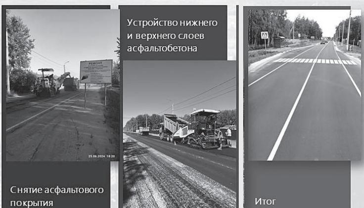
Устройство нижнего и верхнего слоев асфальтобетона
