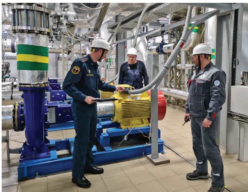
Проведение профилактических работ на объекте
