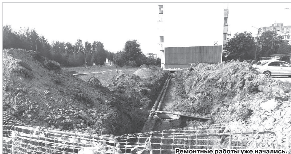
Ремонтные работы уже начались.
