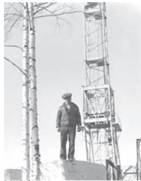
В.М. Бибанин на строительстве здания ЦДМ.
