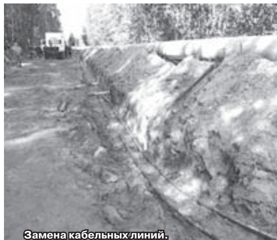
Замена кабельных линий.
