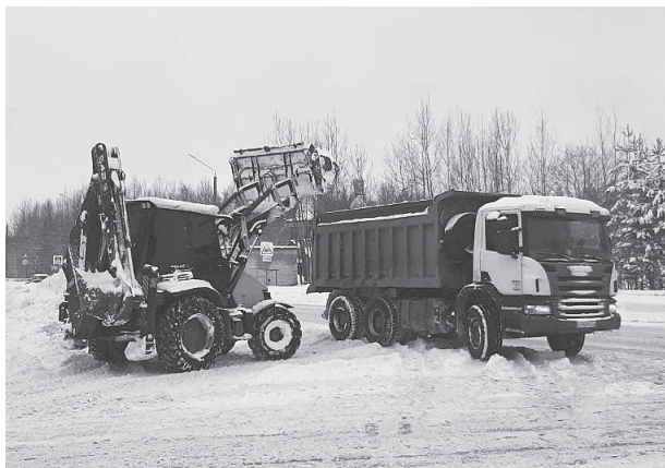
Уборка снега на автодороге в межквартальной полосе.
