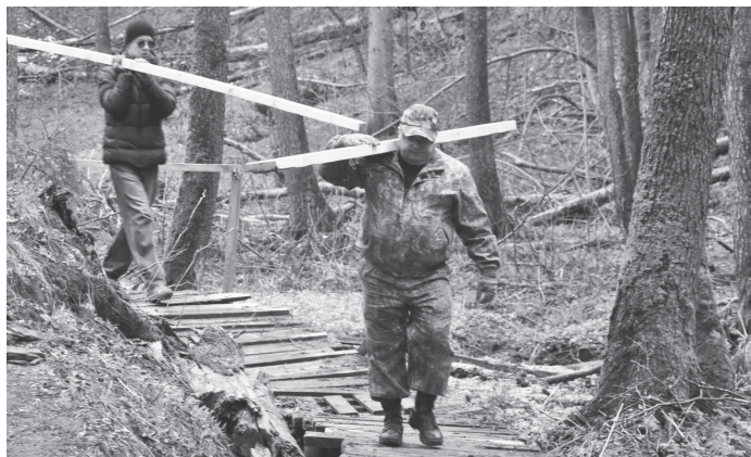
С.В. Лисецкий на ремонте мостков.
