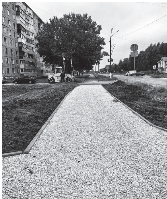
Ремонт кольцевой пешеходной дорожки сзади дома №18 1-го квартала.
