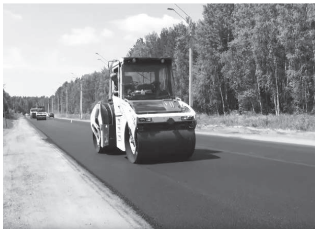
Отремонтирован участок дороги от офиса ЗАО «Электрон» до перекрёстка с поликлиникой.
